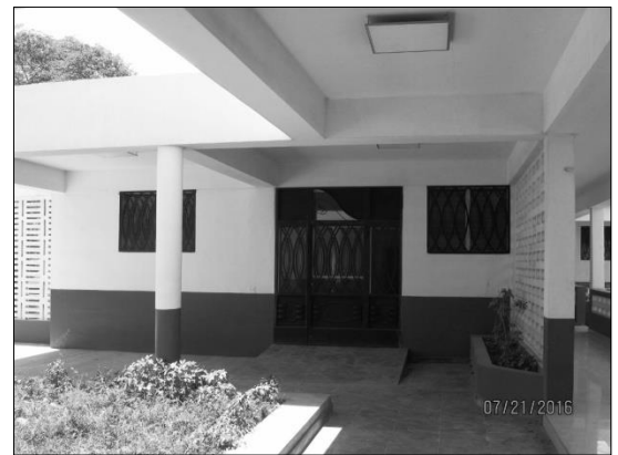
Vues générales du patio de l'hôpital, travaux de la Phase 2
