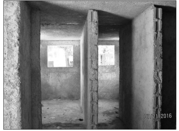
Vue intérieure du futur bâtiment pour petit personnel
