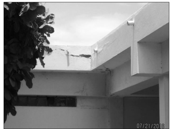
Dégradations notées sur un acrotère
