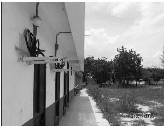
Retrait des climatiseurs extérieurs pour le stockage à l'intérieur
