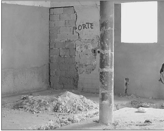
Phase 3, Lot 1: gros œuvre du bloc opératoire
